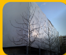
Confinamento per recupero amianto
