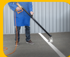
Posa di segnalazione termoplastica
