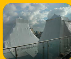
Isolamento cantiere dalle intemperie
